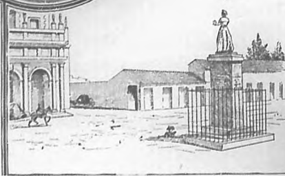
Estatua en bronce de Isabel II colocada el 19 de noviembre de 1840, frente al antiguo teatro Tacón, el mismo día en que se inauguraron las obras de embellecimiento de aquellos lugares que quedaron convertidos en Paseo de Isabel II.
